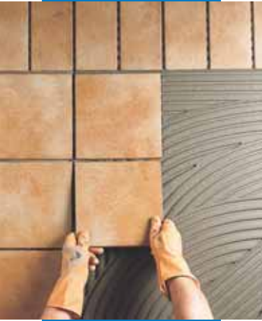
Klinker lapok kültéri ragasztása
