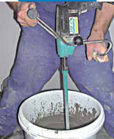
A Planolit 315 bekeverése lassan forgó keverőszárral
