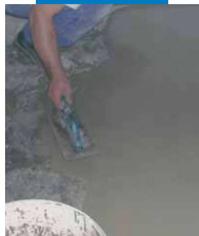
A Planolit 315 elterítése az aljzaton
