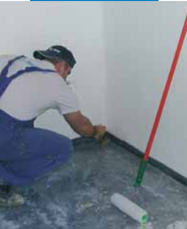
Az aljzat alapozása Primer G-vel a Planolit 315 felhordása előtt
