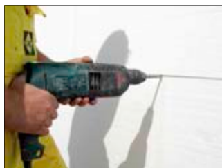
7. Rögzítő dübelek furatainak elkészítése.
