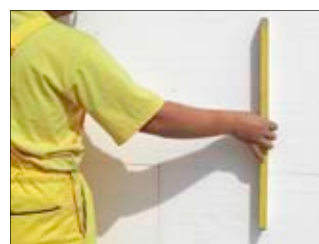
6. A felragasztott felület ellenőrzése.
