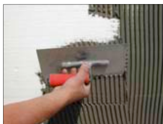
10. Fogazott glettvassal a rendszerragasztó felhordása.
