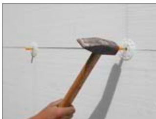
8. Rögzítő dübelek beütése.
