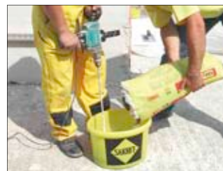
3. Hőszigetelő rendszerragasztó bekeverése.
