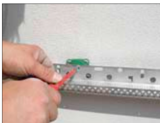
2. Lábazati indítósínek rögzítése.
