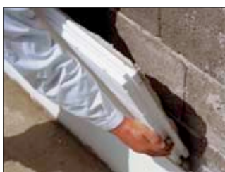
5. A polisztirol lapok felragasztása.
