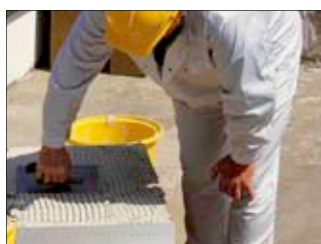
4. A ragasztó felhordása a szigetelő lapra.
