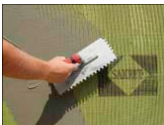
11. Az erősítőháló ragasztóba rögzítése.
