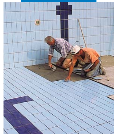
Kerámia burkolólapok fektetése Mapelastic-ra úszómedencében
