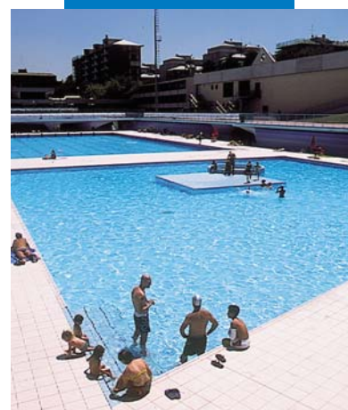
Mapelastic-kal vízszigetelt úszómedence; Scarioni szabadidőközpont - Milánó - Olaszország
