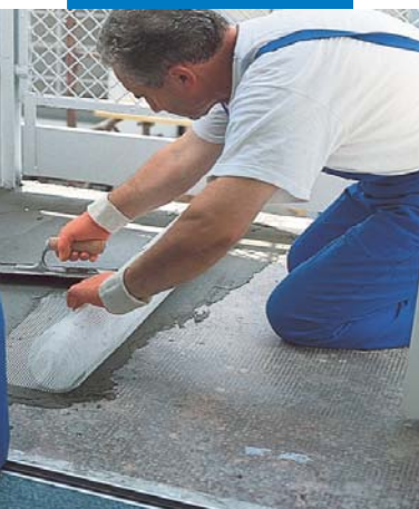
Erkély vízszigetelése üvegszövet-háló erősített Mapelastic-kal
