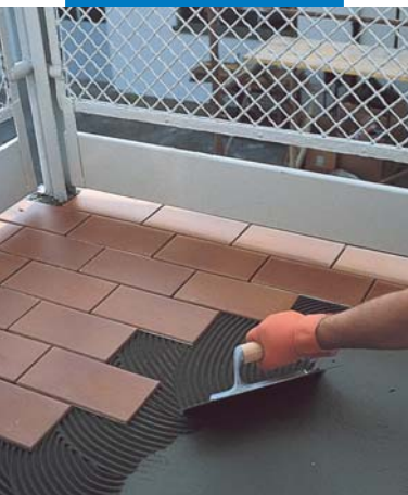
Mapelastic-kal vízszigetelt erkély burkolása Granirapid-dal
