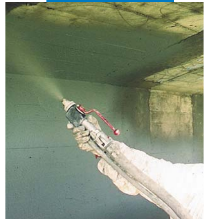
Példa Mapelastic szórásos felhordására viadukon
