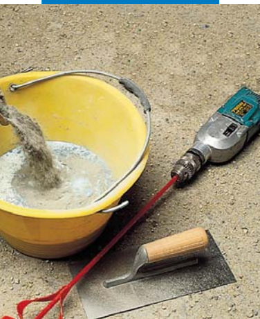
Mapelastic bekeverése mechanikus keverővel
