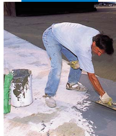
Úszómedence vízszigetelése Mapelastic-kal
