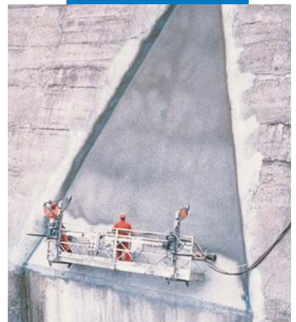
Példa Mapelastic szórásos felhordására gátra
